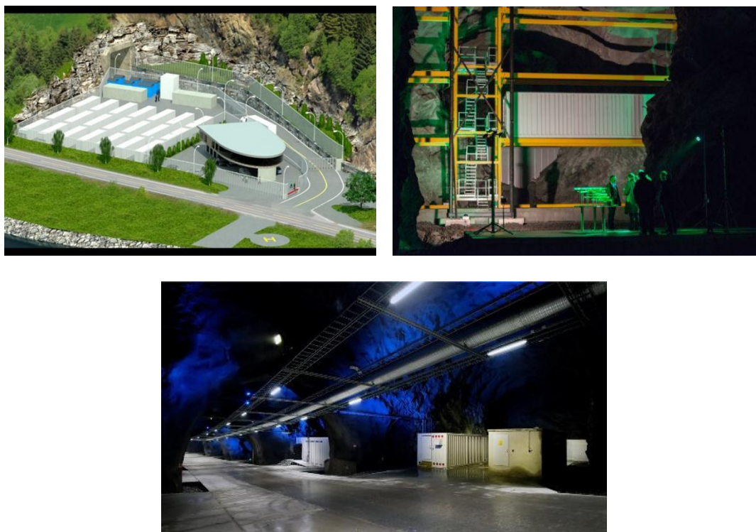
Рисунок 7 – Дата-центр Lefdal Mine Datacenter
